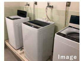
洗濯室 / Laundry Room
